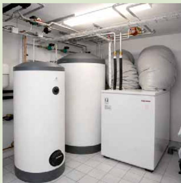
Värmepump WPL 13i med buffert- och varmvattentank.
