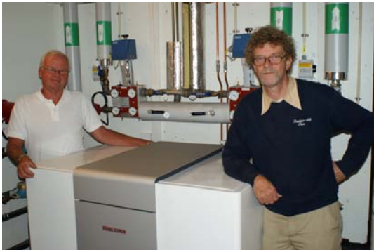
Bengt Gustafsson vid församlingens Bergvärmepump WPF 27 ifrån Stiebel Eltron, tillsammans med Per-Uno Kilander, Installator AB, Installatör och Konstruktör.
